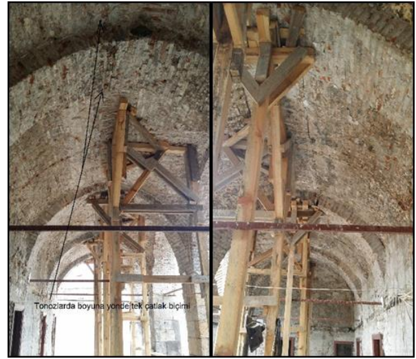
Şekil 6. Tonozlarda boyuna yönlü tek çatlak biçimi (anahtar solunda veya sağında)
