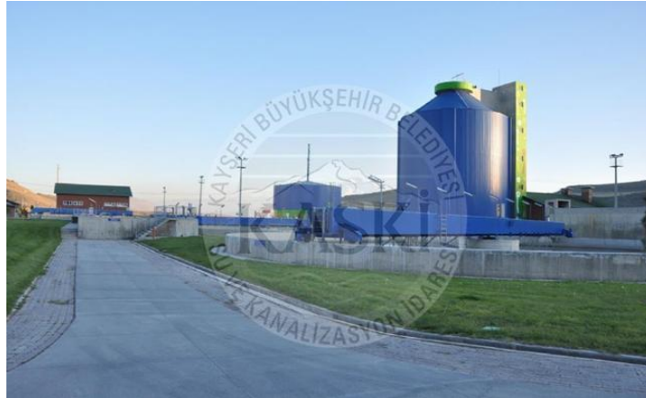
Resim 7: Kayseri atık su arıtma tesisi
