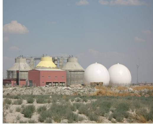
Resim 6: Konya arıtma tesisi biyogaz ünitesi
