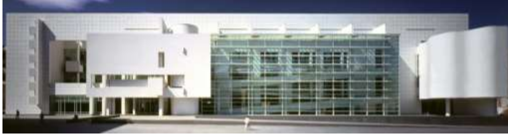
Görsel 10. MACBA güney cephesi.
