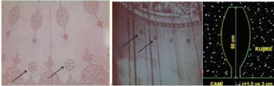
Resim 3. Cami iç mekânında küplerin rezonatör olarak kullanım detayı (Kayılı, 1988b).
