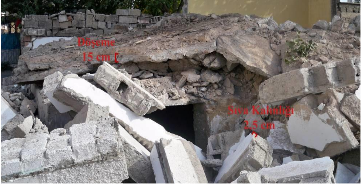
Fotoğraf 3. Küçükali'de 2. Etap Yıkım Çalışmaları [64].
