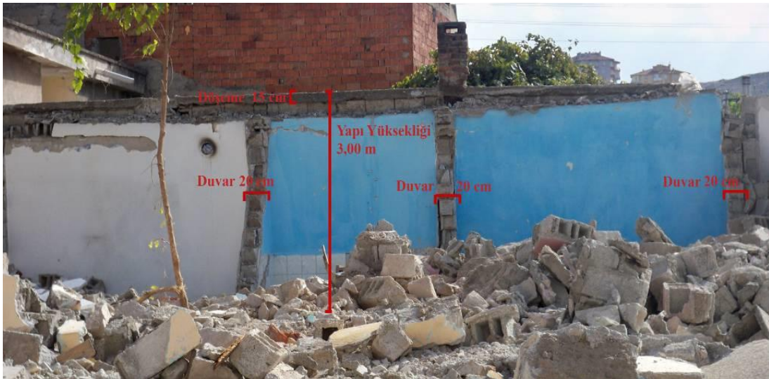
Fotoğraf 4. Küçükali'de 2. Etap Yıkım Çalışmaları [64].
