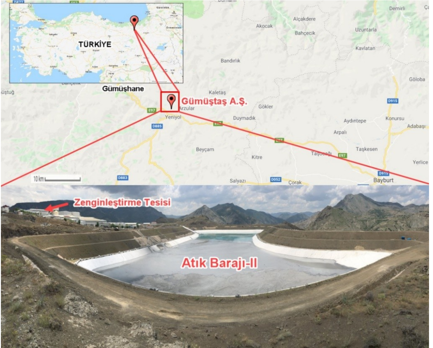
Şekil 1. Çalışma alanının konumu ve atık barajının genel görünümü.
