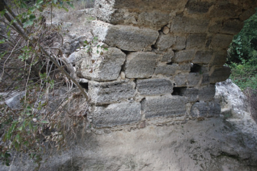
Resim 2: Kurtdere Köprüsü, Batı Ayağı
