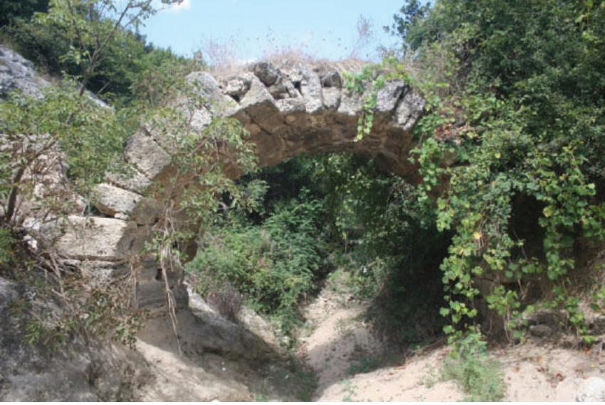
Resim 1: Kurtdere Köprüsü (Güneyden)
