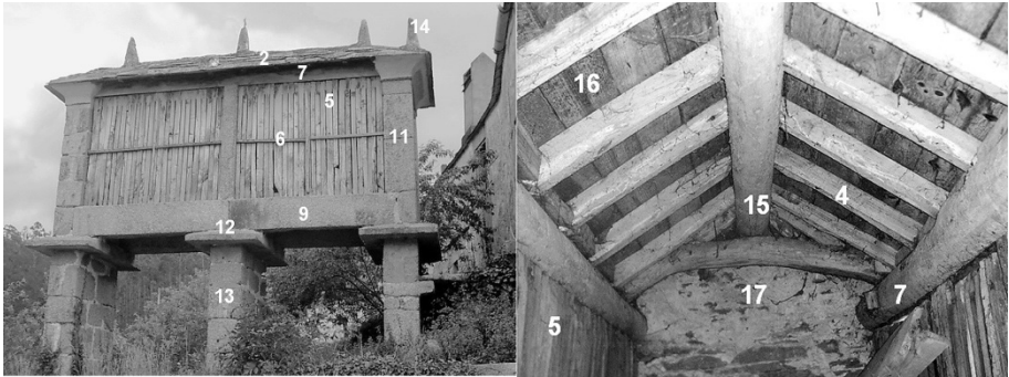
Şekil 22: Galiçya Horreo Yapısal Elemanlar 47
