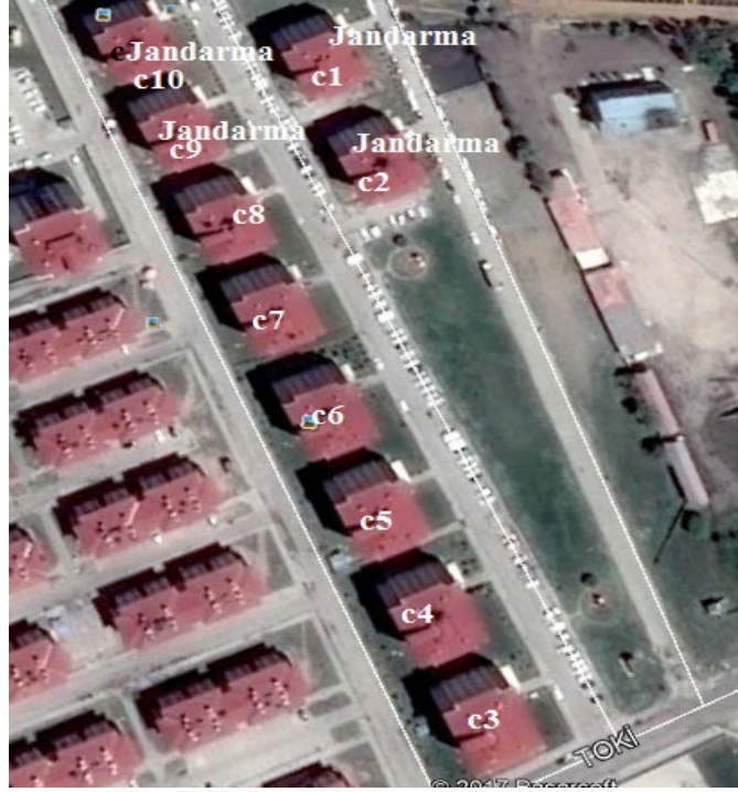
Şekil 1. Ağrı Suçatağı İkinci Etap TOKİ Konutları.
