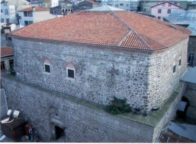
Resim 7. Bedesten'in restorasyon sonrası kuzey cephesi
