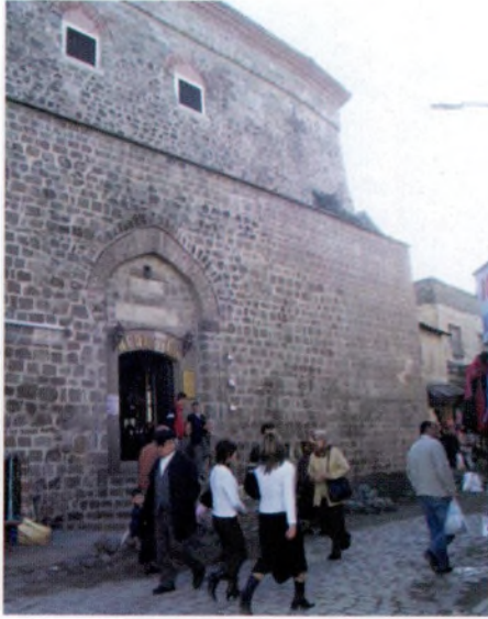
Resim 8. Bedesten'in restorasyon sonrası kuzey girişi
