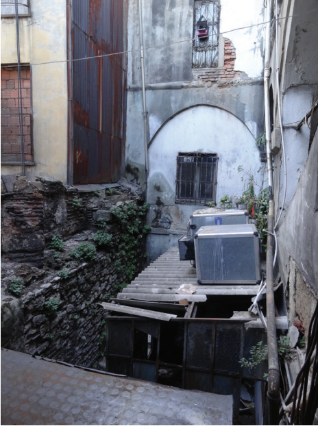
Fot. 8: Avlu ve Kapatılan Revak Kısımları
