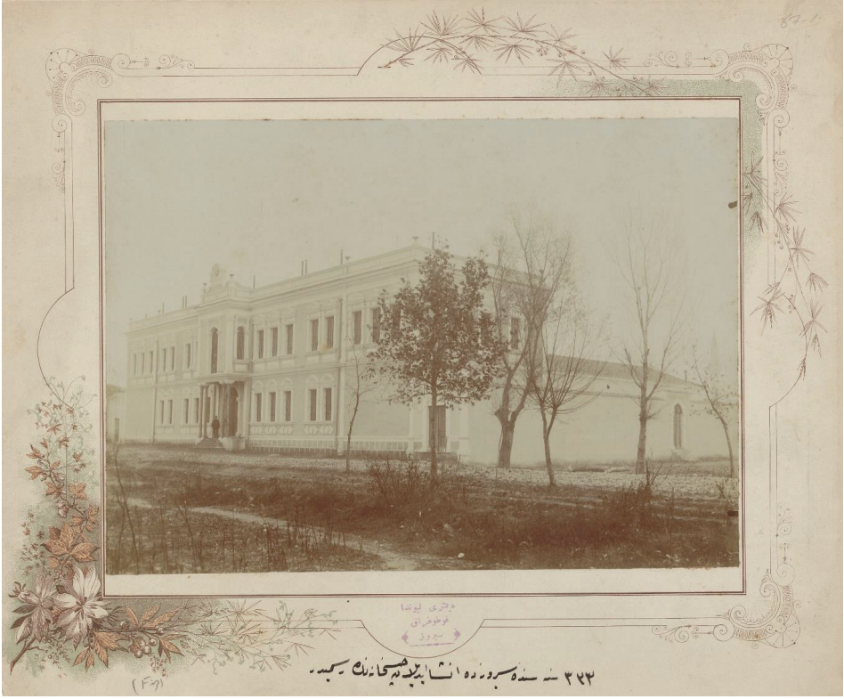
Fot. 1: “323 senesinde Siroz’da inşa edilen hapishanenin resmidir” açıklamasıyla verili Arşiv fotoğrafı. (DAB Osmanlı Arşivi - FTG. f. 213)
