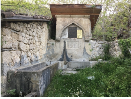
Fot. 5: Güney cephe görünümü
