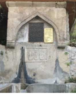
Fot. 7: Güney cephe görünümü
