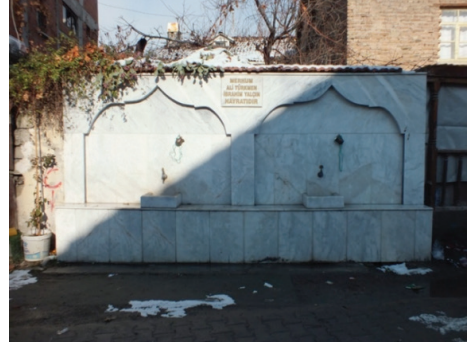
Fot. 27: Güney cephe görünümü (2016)
