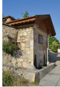
▶ Fot. 4: Güneybatıdan görünüm
