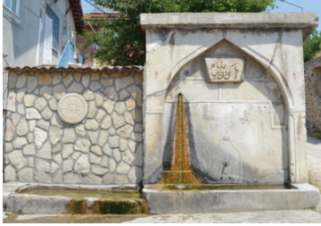
Fot. 37: Güney cephe
