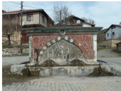
Fot. 32: Güney cephe görünümü
