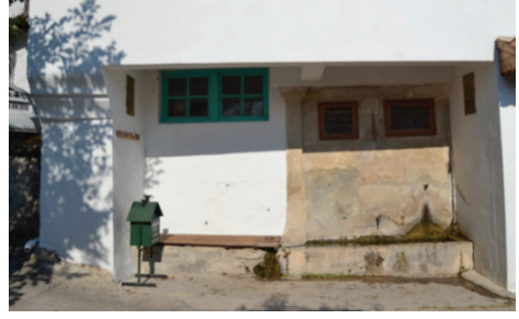
Fot. 10: Batı cephe görünümü
