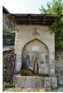
Fot. 19: Güney cephe
