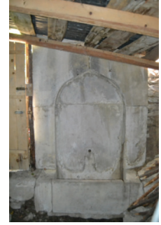
Fot. 20: Batı cephe
