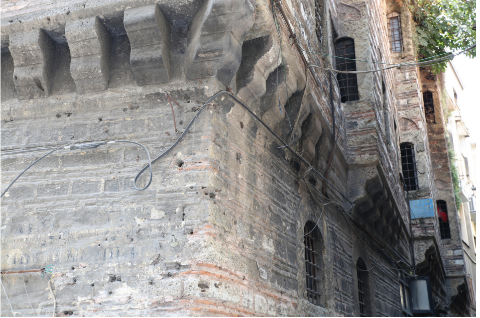
▼ Fot. 6: Profilli Taş Konsollara Oturan Çıkmalar
