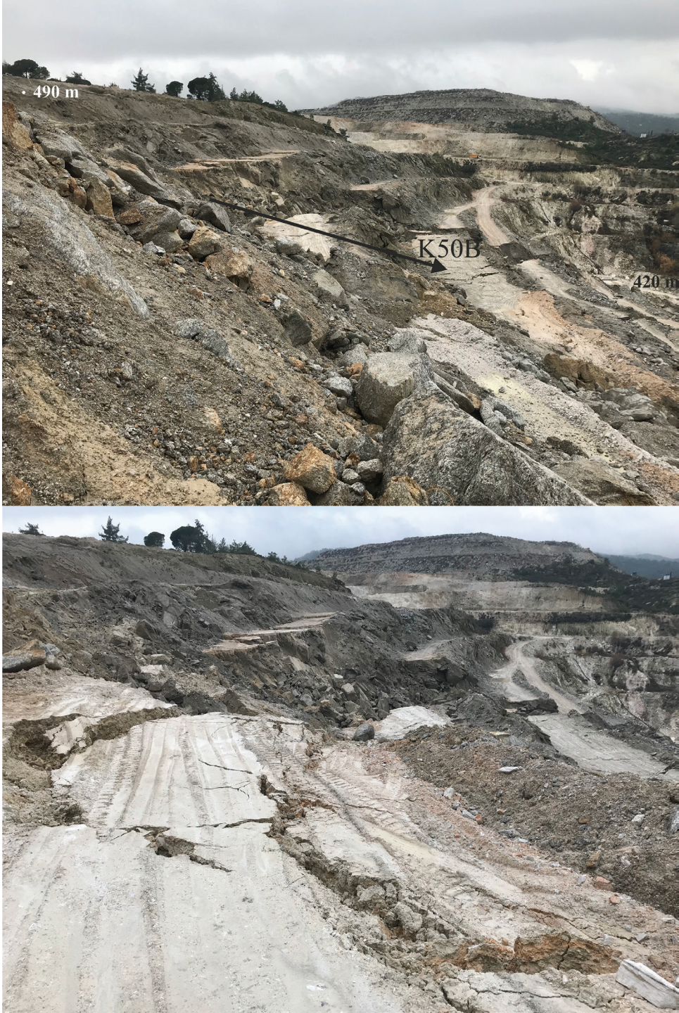
Şekil 1. Yenilme sonrası heyelan topoğrafyası (Foto:19.12.2018, sabah-7.30).
