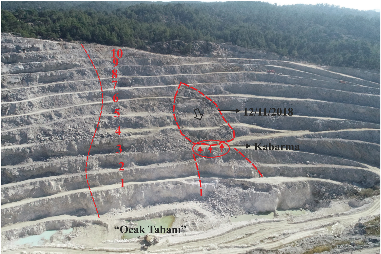
Şekil 10. Yenilme öncesindeki ilk şev deformasyonları ve 12.11.2018'de meydana gelen öncü-küçük heyelan (1, 2, 3, ..., 10: şev kademeleri).
