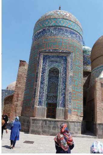
Resim 4: Şeyh Safiyyüddîn Mezar Kulesi/Türbesi
