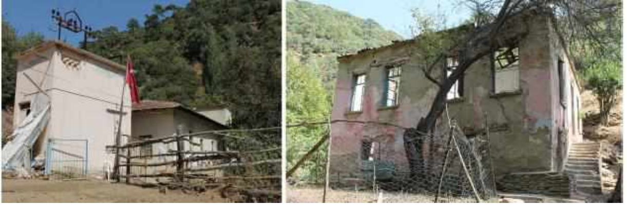
Şekil 10. Lübbey köyü tarihi elektrik santrali ve lojmanından görüntüler (Güler, 2016)
