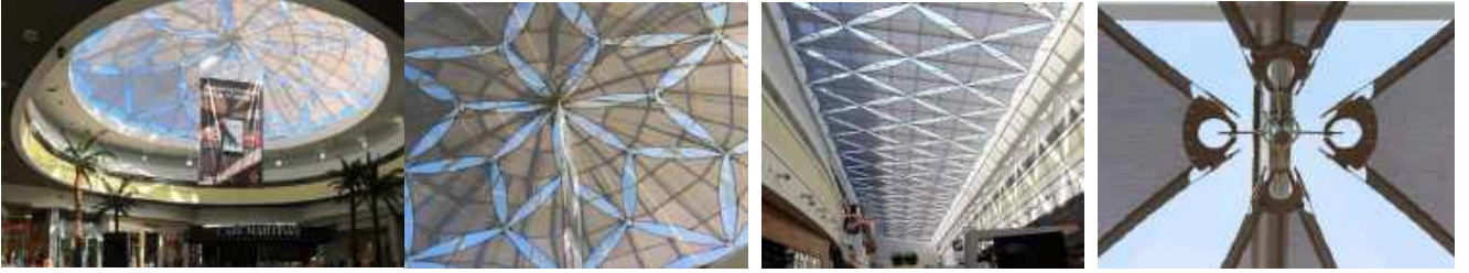
Şekil 5. Alto Avellaneda Alışveriş Merkezi'nin iç örtü sistemi. (URL-5)
