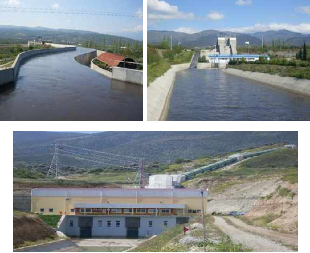
Şekil 1. Türkiye'de inşa edilen ve işletilen bazı kanal HES'leri
