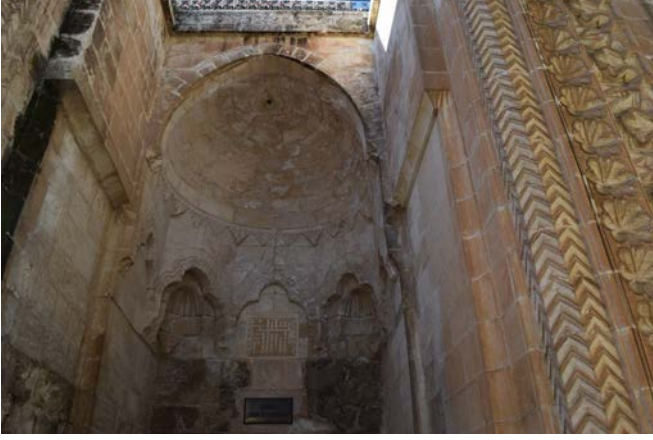
Fotoğraf 9- Şehidiye Camii Taç Kapısı Genel Görünüşü
