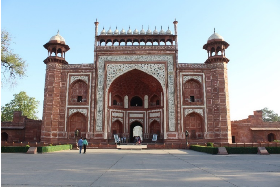
Fotoğraf 1: Darvaza-i-Ravza Kapısı Güney Cephe Genel Görünüşü (Özler, 2016)
