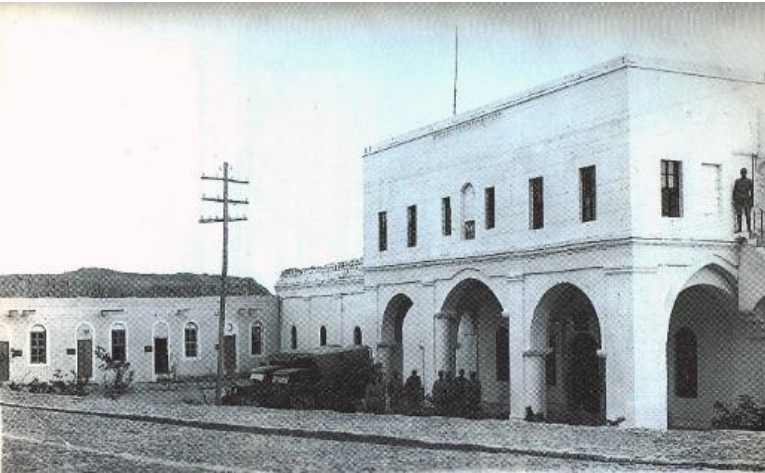
Resim 22. Binarın XIX. yüzyıl kışlası (Bekin, 2010: 167) dönemindeki giriş mekanı
