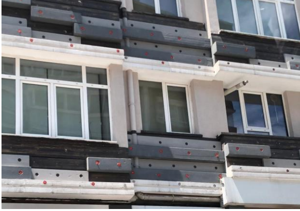
Şekil 15. Yenilenen bina cephelerinde onarım yapılması
