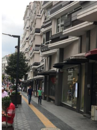
Şekil 9. Caddedeki binaların zemin kat cepheleri
