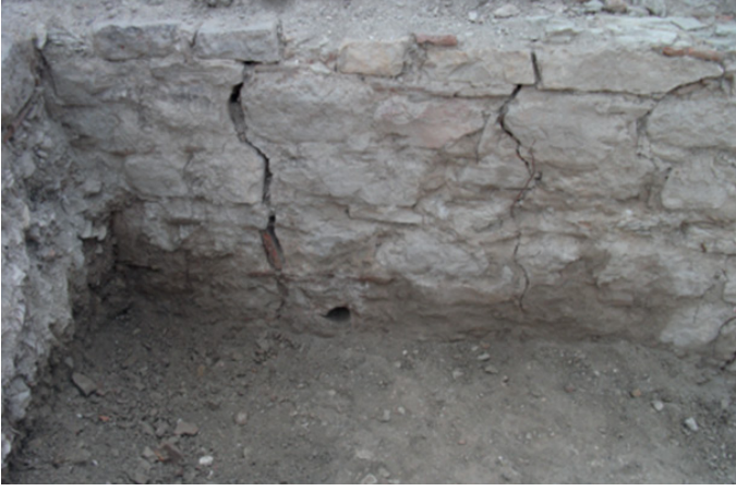
Figür 38. Hereke Kalesi Kazısında duvarda deprem izleri
