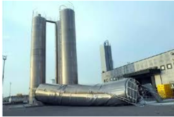
Şekil 2. Çelik silolarının çökmesi (Collapse of Silos)
