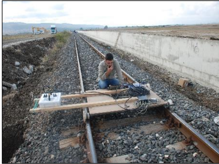
Şekil 3. Demiryolu GPR uygulaması (Railway GPR application)
