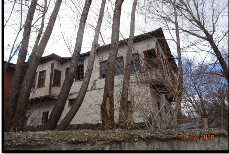
Fotoğraf 6. Pınarbaşı İlçesindeki Restore Edilmesi Gereken Evlerden Görünüm.
