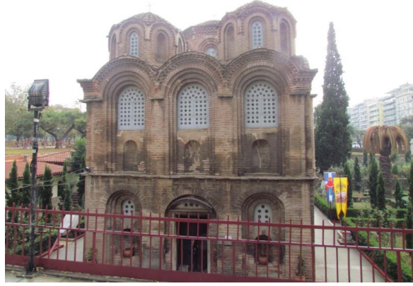
G.13.Panagia ton Khalkeon Kilisesi, batı cephe (Foto. yazara ait, 2018).
