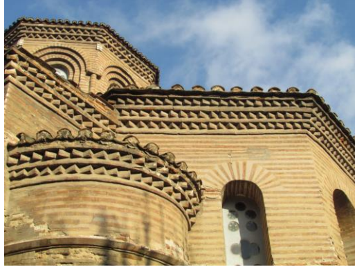
G.15.Panagia ton Khalkeon Kilisesi, doęu cephe, detay: kpek diři frizler (Foto. yazara ait, 2018).
