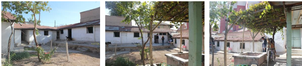
Şekil 13: 1 Nolu konutun bahçeden görünüşü (Sungur, 2017)
