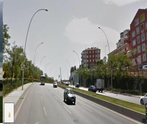
Resim 8. Elektrik Direk ve Kablolarının Yer Altına Alındığı Bir Uygulama- (Google maps)Ankara 06.04.2020
