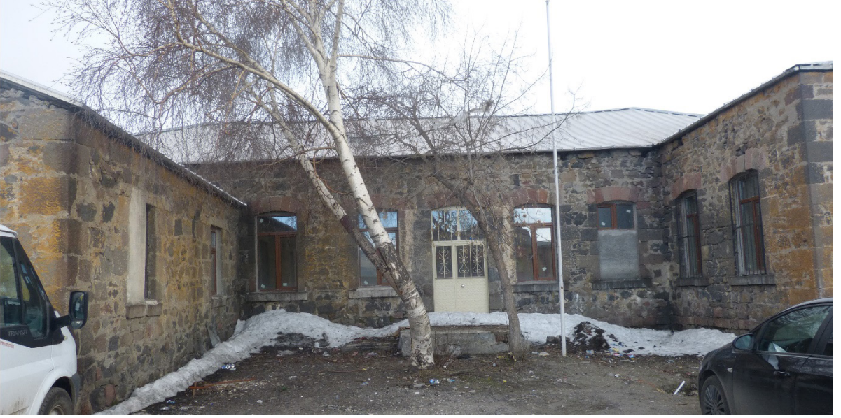
Resim 45- Ardahan İl Halk Kütüphanesi olarak kullanılan tarihi binanın arka cepheden genel görünümü.
