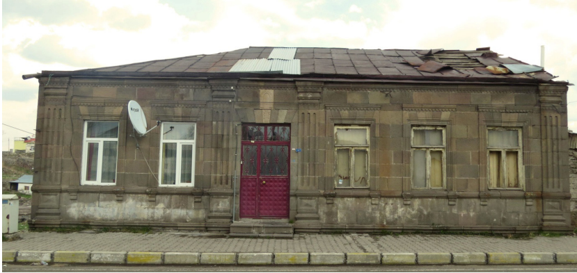
Resim 37- Abdullah Öđüt Evi'ndeki güney cephe genel görünüm.
