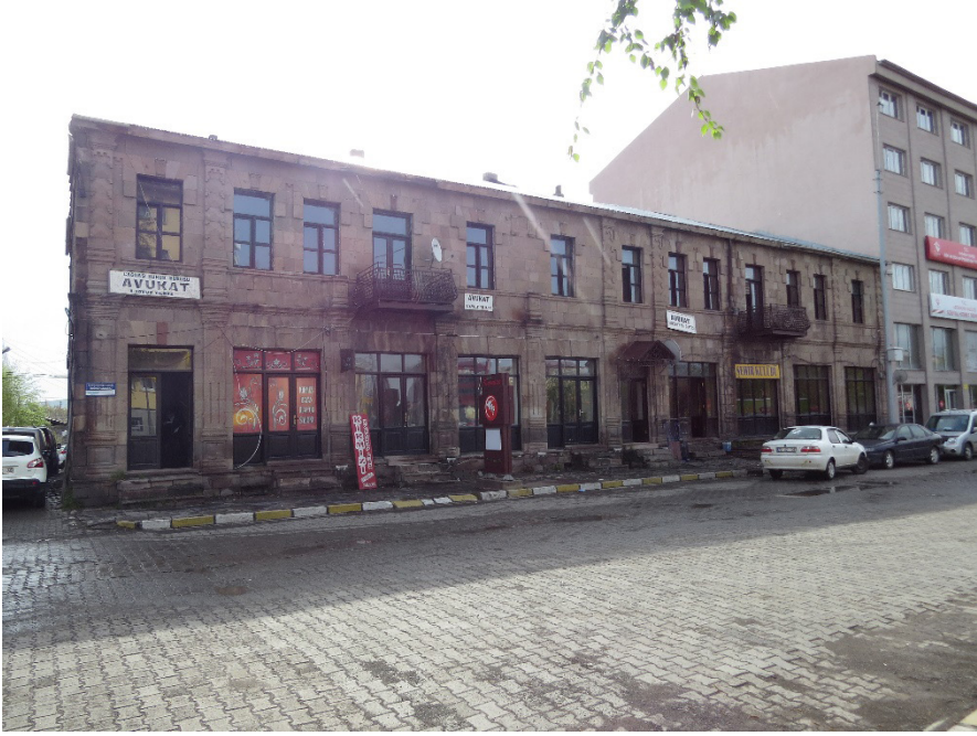
Resim 20- Tat Abdullah Karaca Konağı batı cephe genel görünüm.
