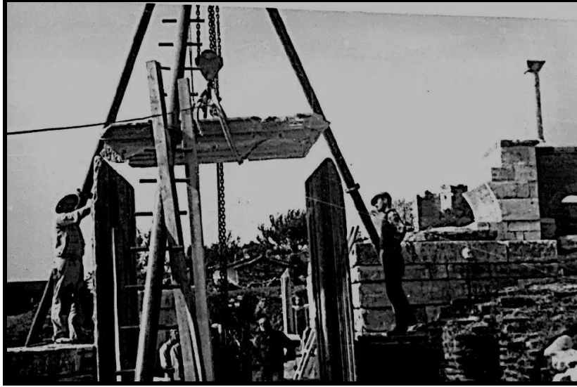
Res. 2: St. Jean Kilisesi Nartex güney kapısı restorasyon çalışmaları sırasında. (Baran 1961, lev.10.b)
