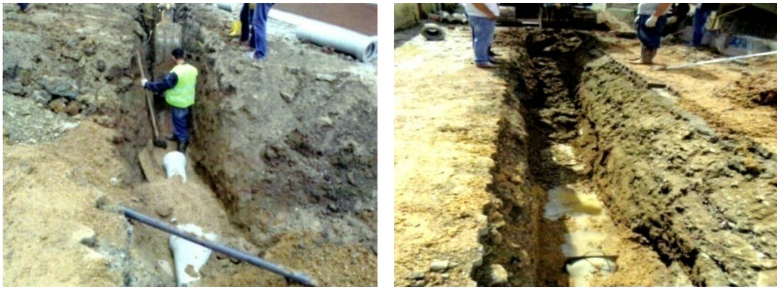
Res. 19-20: Cumhuriyet Mahallesi Kanalizasyon Alt Yapı Çalışmasından Görüntüler
