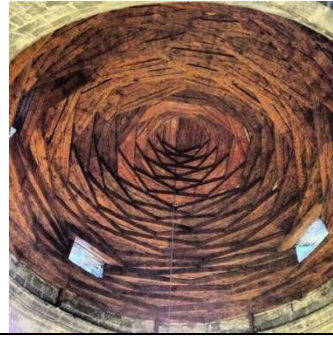
Şekil 1B: Kırlangıç tavan örneği 7
