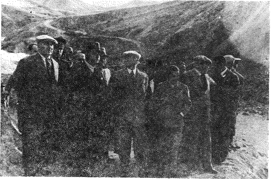
Dersim (Tunceli)'de Arazi İncelemesi (1937)
