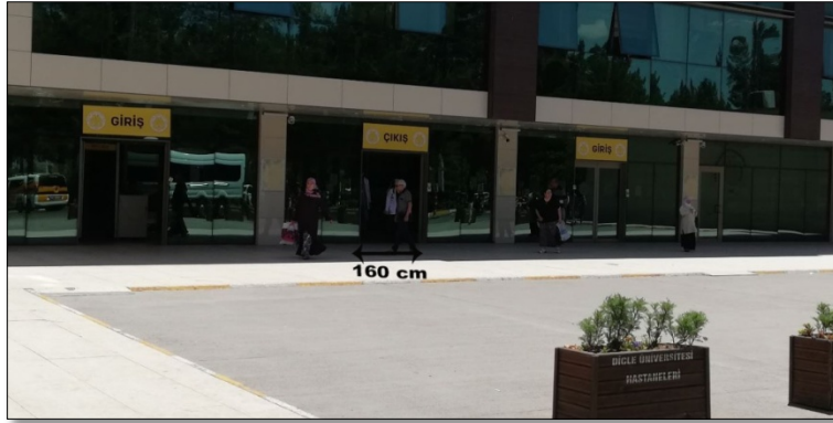
Şekil 7a. Üniversite Hastanesi bina girişi
