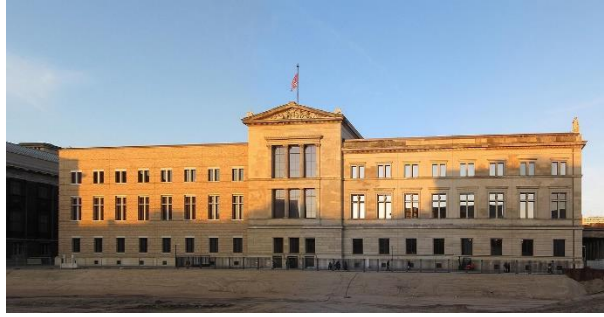
Şekil 22. Yeni Müze yapısının ön cephesi (2009) (URL-14)
