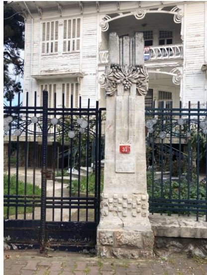
Şekil 8. Betonarme sütun (Selvi, 2020)
