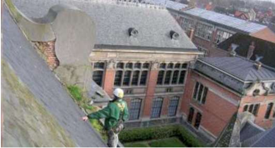
Şekil 3. Çatı üzerinde inceleme çalışması Antwerpen/Belçika
