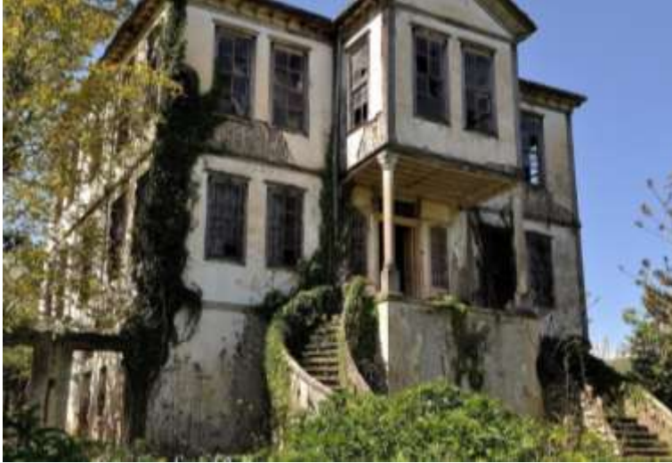
Őekil 1. Düzenli bakım yapılmadıđı için oluşan otsu bitkiler, Cevat Bey Konađı, ÇamaŐ/Ordu ("Gezginin seyir defteri", 2017)
