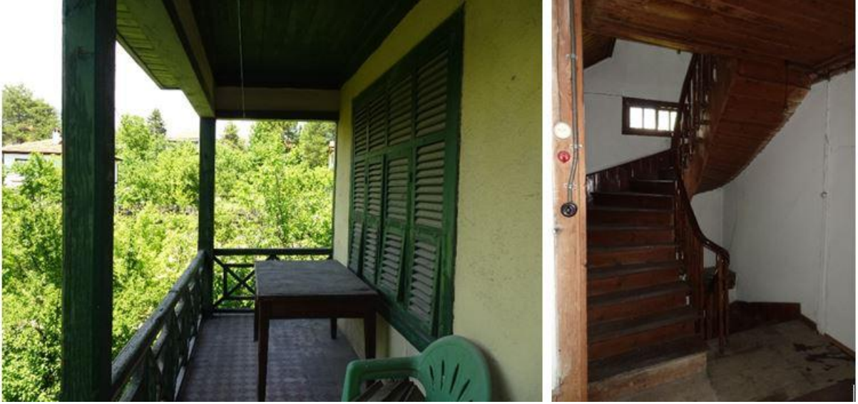
Şekil 35-36: Yan Cepheye Bakan Balkon (Solda) ve Merdiven (Sağda)
