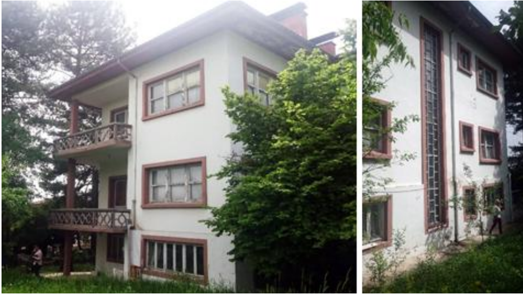
Şekil 13-14: Ganioglu Konağı Doğu ve Batı Cepheleri
