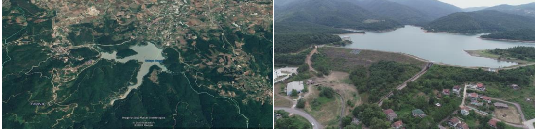
Şekil 1. Gökçe Barajı rezervuar alanı ve gövdesinin genel görüntüsü.
