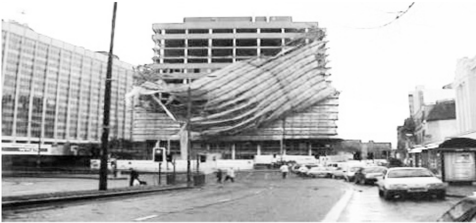
Resim 1: İskelede bağlantının kopması.
