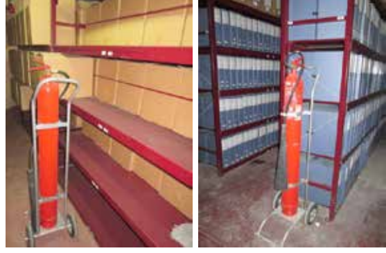
Şekil 7: Topkapı Arşiv Binası (solda) ve Merter Arşiv Binası (sağda) hareketli yangın söndürücüleri.
