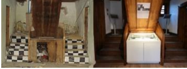
Şekil.34- Yağcızade Konağı İç Mekân Restorasyon Çalışmaları
