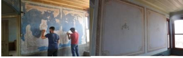
Şekil.44- Dalyancı Konağı İç Mekân Restorasyon Çalışmaları
