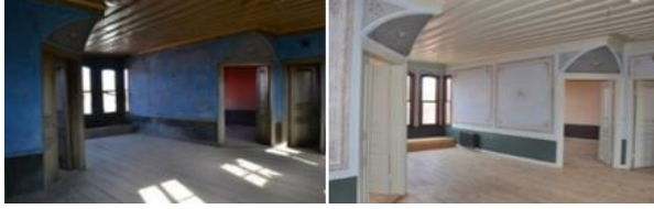
Şekil.43- Dalyancı Konağı İç Mekân Restorasyon Çalışmaları
