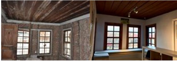
Şekil.35- Yağcızade Konağı İç Mekân Restorasyon Çalışmaları
