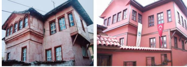
Şekil.47- Hafız Ahmet Efendi Konağı Restorasyon Öncesi , Şekil.48 - Restorasyon Sonrası
