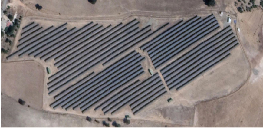
Şekil 4. Güneş enerjisi santrali
