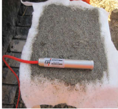
Şekil 16. Piyezometrenin kum filtre ile sarılması
