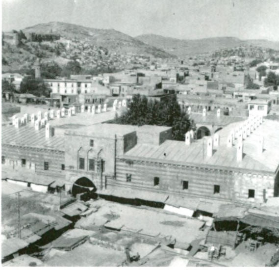
Res. 1 - Gümrük Hanı genel görünüm.
