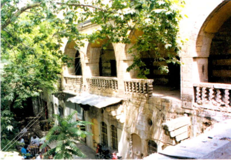
Res. 2 - Gümrük Hanı, avlu kuzey revakları.
