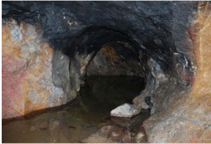
Şekil 6. Çekya'da bulunan eski bir madende ateş kurma ile kazı sonrası tavanda oluşan is (Lednicka ve Kalab, 2016; Fotoğraf: Lednicka).
