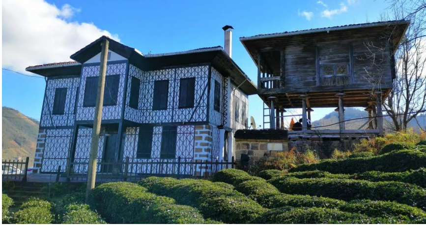
Şekil 1. Serender konut ilişkisi, Sürmene-Aksu Mahallesi/Trabzon
