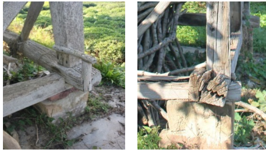
Şekil 7. Serenderin zeminle bağlantısı
