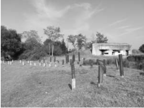
Ek 21. a. Çatalca Bahşiyiş Köyü Korugan önünde birçoğu kesilmiş ejderişleri.
