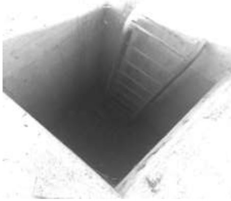
Ek 15. h. Üçüncü ve dördüncü tip koruganların altında genellikle sığınaklar bulunmakta bu sığınaklara merdivenle inilmekte ve çıkılmaktadır.
