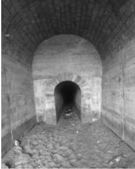
Ek 18. d. Çatalca Dağyeniçe Köyü en büyük koruganın giriş tüneli.
