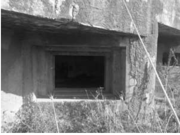
Ek 15. j. İçerisine top yerleştirilen üçüncü tip koruganın dış pencere görünümü.
