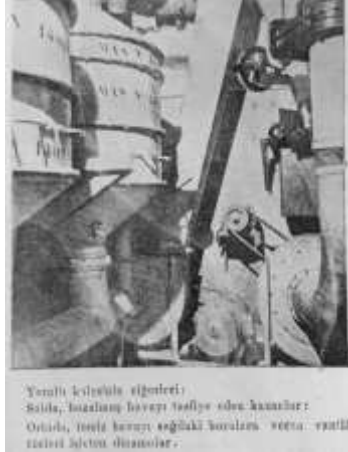
Ek 14. e. Majino Hattı'ndaki bir koruganda havalandırma sistemi. Kaynak; Hamdi Turgay, a.g.m., s. 562. Çakmak Hattı'ndaki havalandırma sistemi bunun aynısıdır.
