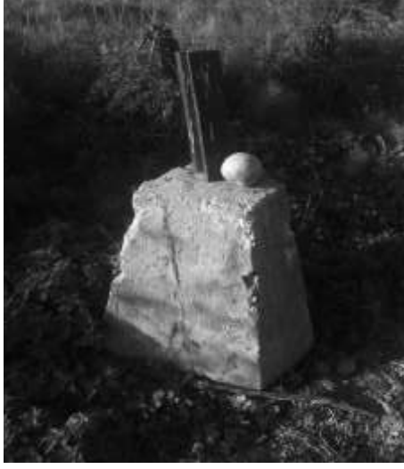
Ek 2. İstanbul Çatalca Yazlık Köyü. Ejderdişleri (anti-tank cubes) genellikle betondan ve ray demirlerinden yapılmıştır. Çatalca-Büyükçekmece, Çakmak Hattında betondan yapılmış ejderdişlerinin üzerine genellikle ray demirleri de eklenmiştir.
