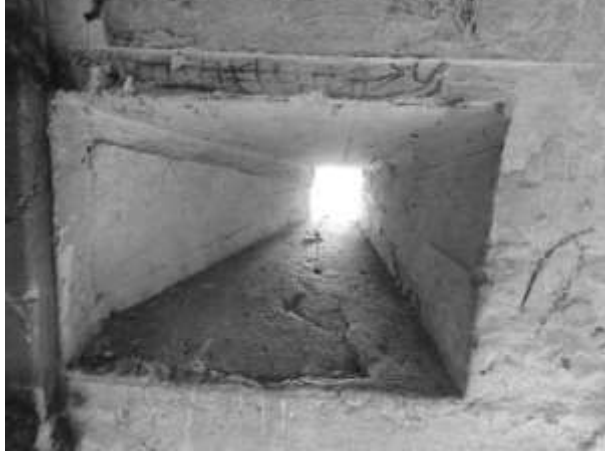
Ek 16. 1. Dördüncü tip koruganda içerden dışarıya doğru daralan atış penceresi.
