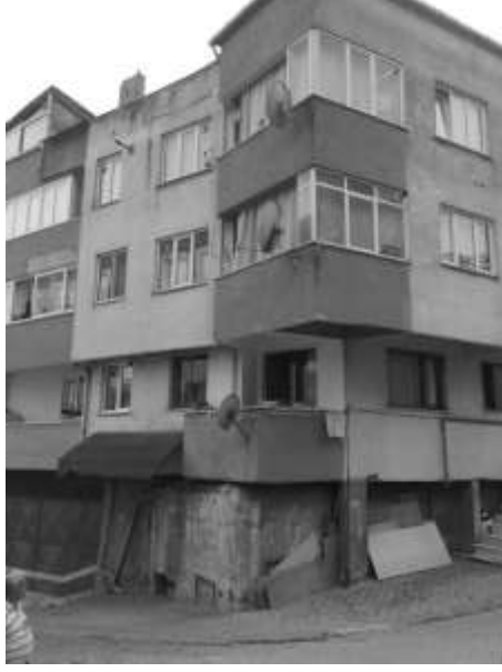
Ek 7. b. Büyükçekmece ilçesi 19 Mayıs Mahallesi Yıldız Sokakta korunanın üzerine dört katlı bina yapılmış, korugan bir nevi temel görevi görmüştür.
