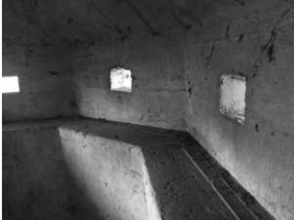
Ek 16. k. Dördüncü tip koruganın sağ ve sol kanatlarında yukarıdaki gibi makinalı tüfeklerle atış yapılan pencerelerin içeriden görünümü.
