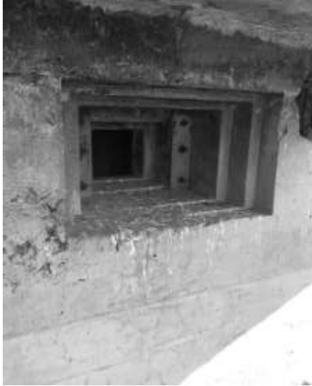
Ek 15. i. İçeriden makineli tüfek yerleştirilen üçüncü tip koruganın dış penceresinin görünümü.
