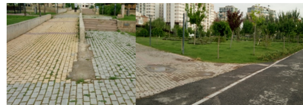
Şekil 11. Zemin Kaplamaları ve Birleşim Noktaları
