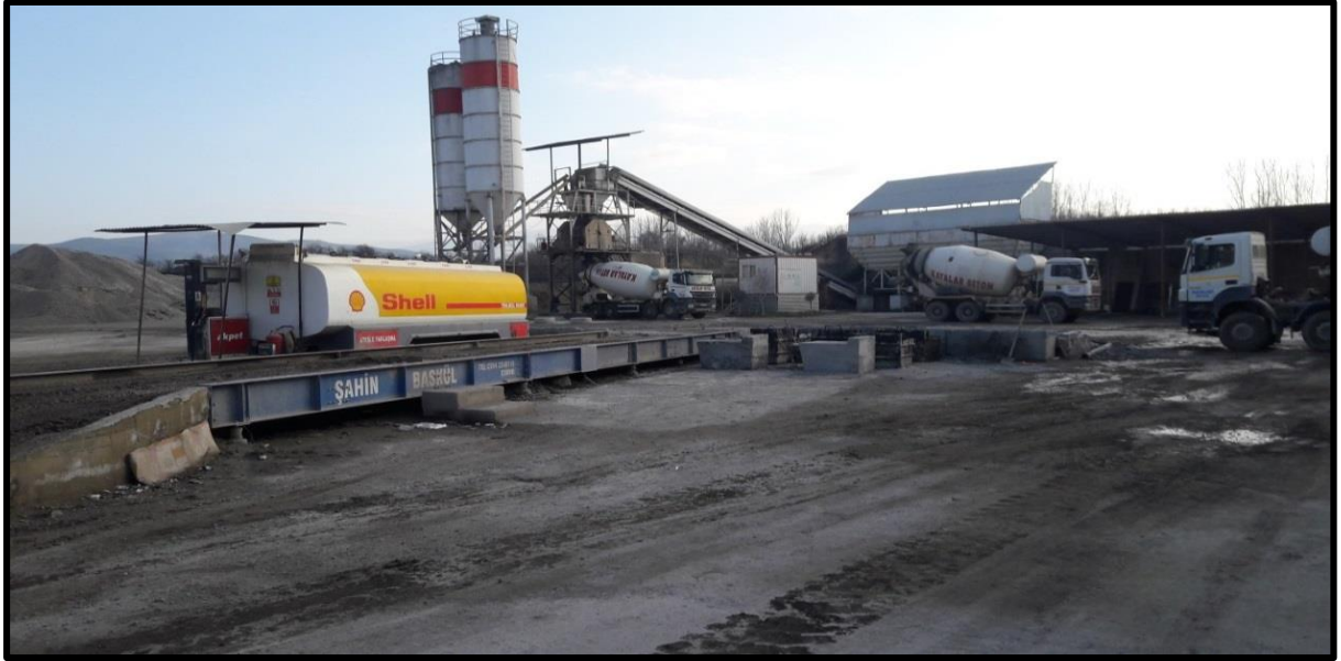
Şekil 15. Kayalar Hazır Beton Tesisleri (08.01.2018).
