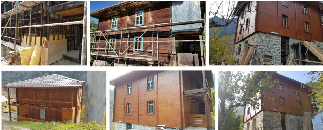
Şekil 28. İrem Camisi onarım aşamaları ve sonrası (Rümeysa Coşkun, 2019)
