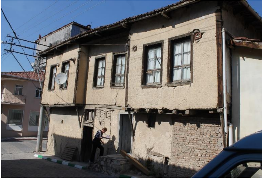
Şekil 9: Güney cephesinin Karakol Sokağı üzerindeki girişi (GTÜ Restorasyon Arşivi, 2016).
