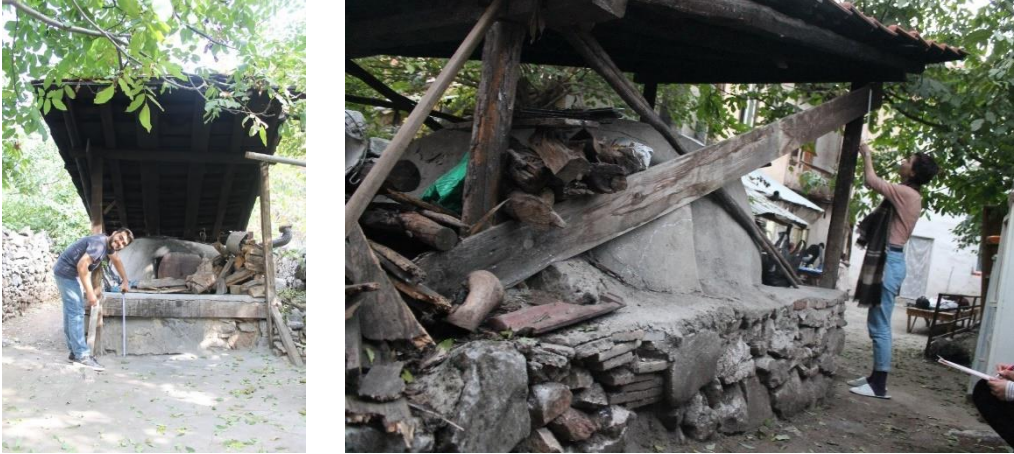
Şekil 11: Yapının bahçesindeki fırın (GTÜ Restorasyon Arşivi, 2016).
