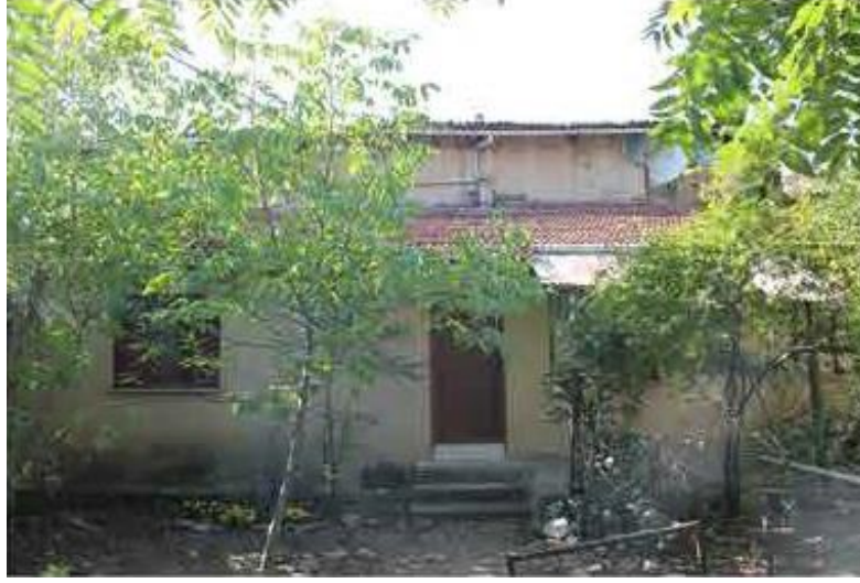
Şekil 18: Yapının doğu cephesini kaplayan tek katlı betonarme ek yapı (GTÜ Restorasyon Arşivi, 2016).
