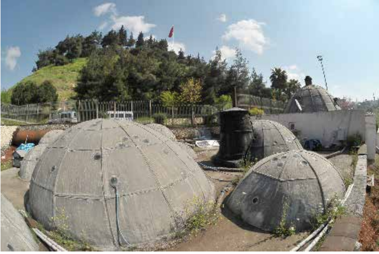
Fotoğraf 12: Çukur Hamamı'nın yıkanma odaları kubbelerinin dıştan görünümü Kaynak: http://kahramanmarassehirrehberi.com/tr/icerik/cukur-hamami
