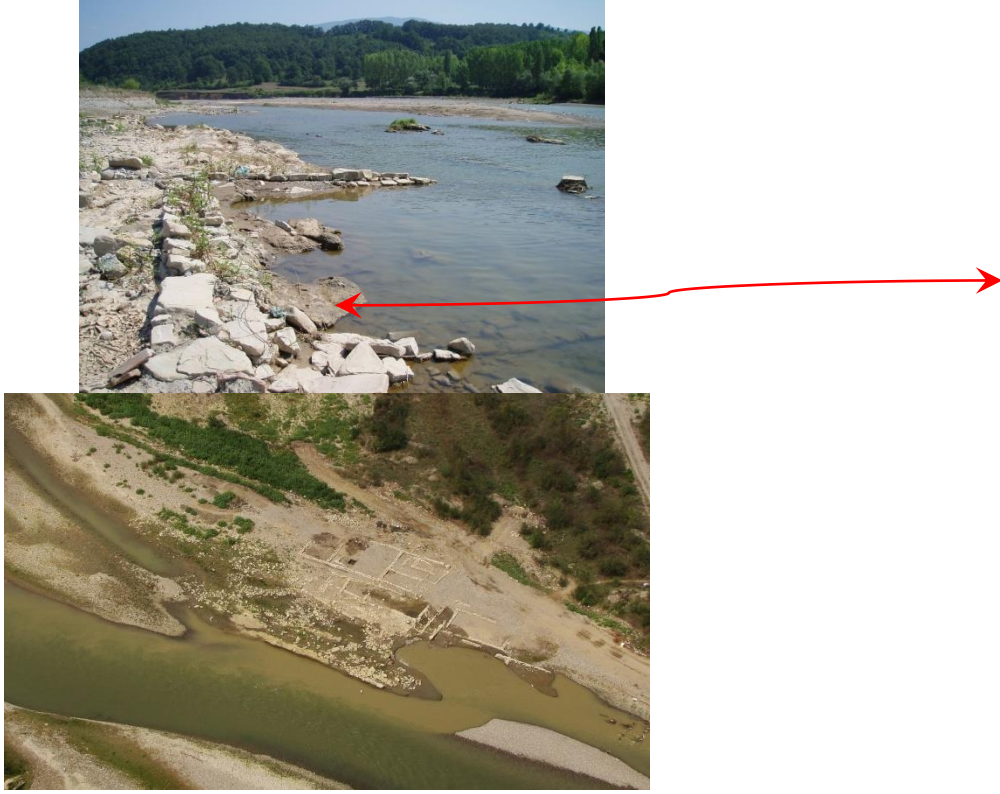
Figür 16-17: Defineciler tarafından tahrip edilen gümrükleme binası olduğu düşünülen yapı.
