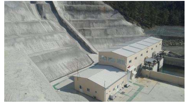
Şekil 5. Namnam HES binası ve cebri boru
