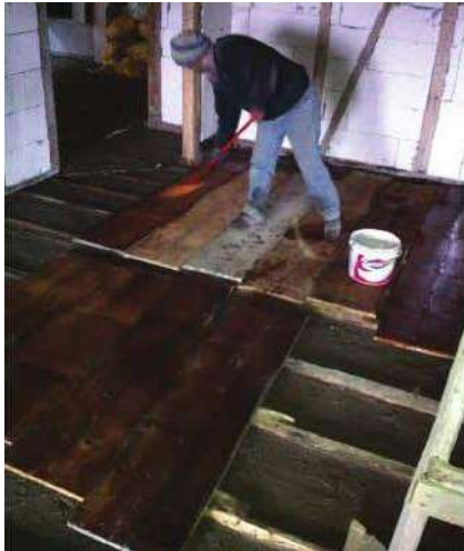
Şekil 16. Safranbolu geleneksel konutların ara kat döşemesinde bulgurlama yapımı (Canbulat, 2012).
