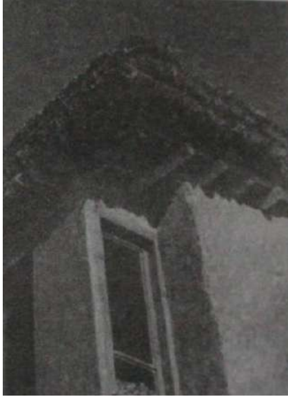
Şekil 14. Konya / Akşehir / Yeşilköy geleneksel konutlarında kamışlı düz çatı örtüsü (Çelebi, 2012).
