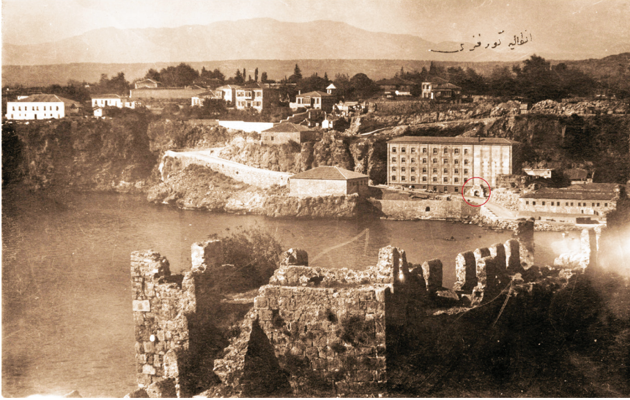
Ek 11: “Hasbahçe Kapısı” adıyla da bilinen II. Bahçe Kapısı’nın yıkıntıları.
