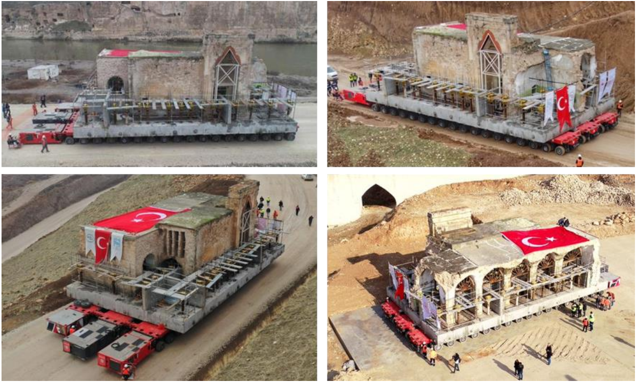
Resim 12. Hasankeyf Er Rızk Camii Revaklı Mekân Kütlesi Bloğu Strüktürel Bütüncül Taşıma Projesi Kapsamında 22Akslı 3 Sıradan (Toplam 66 Aks) Oluşan SPTM Taşıyıcı Platform Üzerinde Arkeoark Alanındaki Yeni Konumuna Taşınması (ER-BU İnşaat Tic. Aş. arşivi).
