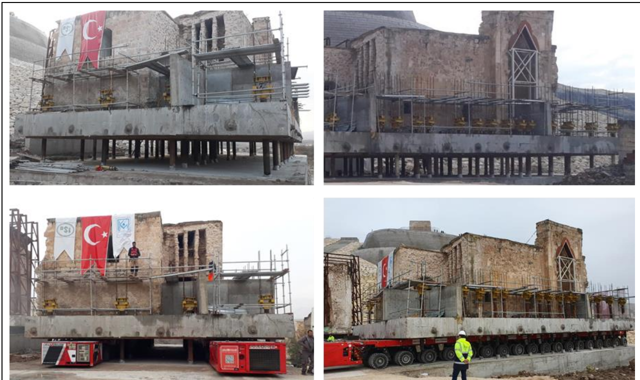
Resim 11. Hasanköy Er Rızk Camii Revaklı Mekân Kütlesi Strüktürel Bütüncül Taşıma Projesi Kaldırma Kriko Sistemininyle Kaldırılması ve SPTM taşıyıcı platform üzerine Alınması (ER-BU İnşaat Tic. Aş. arşivi) .
