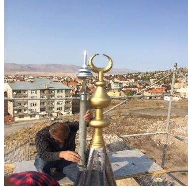
Foto. 44: Alemin ve Paratonerin Yerleştirilmesi
