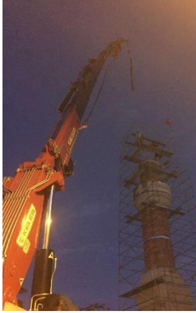
Foto. 38: Seren Direğinin Vinç Yardımı İle Minare Merdiven Taşının Üzerine Yerleştirilmesi
