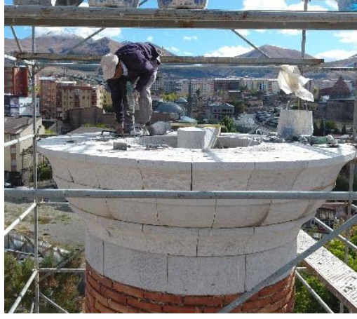
Foto. 29: Taşların Matkapla Delinmesi ve Kancaların Atılması
