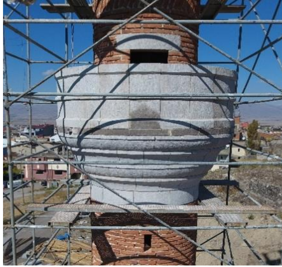
Foto. 35: Dramazon Taşının Yerleştirilmiş Hali
